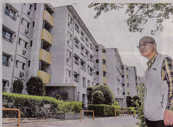
1968年に建てられ、大規模修繕した「花見川住宅」と管理組合の大塚仁理事長＝7日、千葉市
